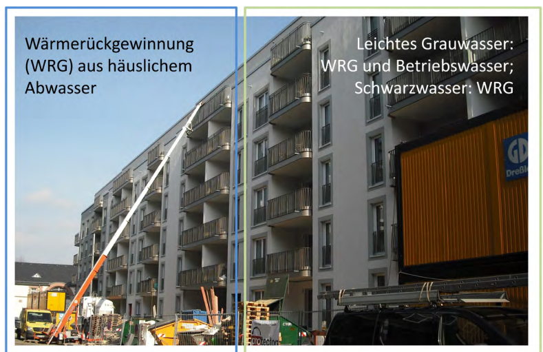
Ansicht des im Bau befindlichen Wohnblocks mit Beschreibung, wie Wärmerückgewinnung und Grauwasserverwertung in den jeweiligen Gebäudehälften implementiert werden. Das Betriebswasser wird für die Toilettenspülung genutzt.
